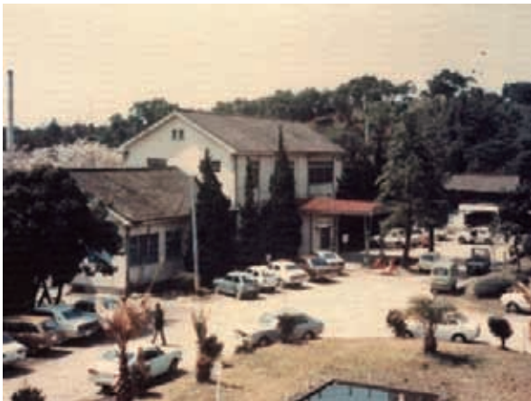
昭和51年 改修前の正門付近と外来管理棟
