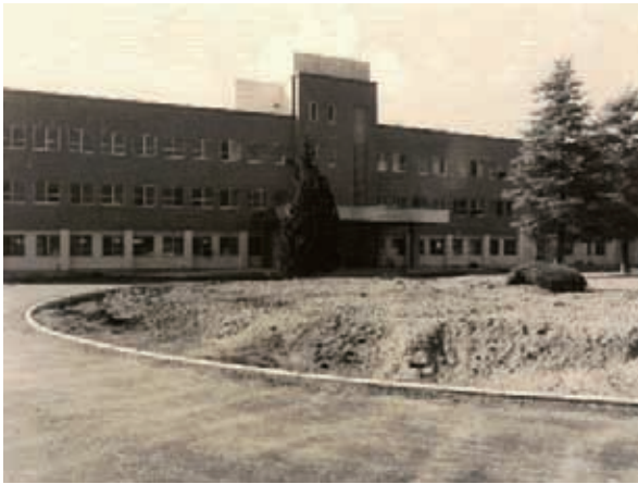
昭和53年 竣工時の外来管理棟
